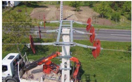
33. fotó: Terelőlemez szerelése feszítőoszlopra (Fotó:EDF-DÉMÁSZ).
