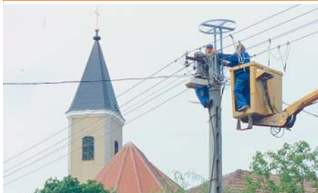
25. fotó: Gólyafészkek-magasító felhelyezése (Fotó: Lovászi Péter).
