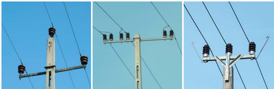
11-13. fotó: Tartóoszlopok: (11) háromszög vezetőelrendezés (ez a leggyakoribb szerkezet); (12) egysíkú vezetőelrendezés ketős felfüggesztéssel; (13) egysíkú, szűkített vezetőelrendezés leesés-gátóval (Fotó: Demeter Iván).
