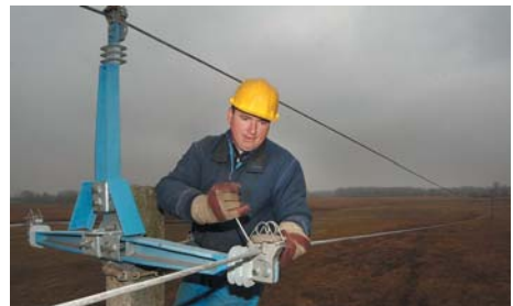
35. fotó: Új típusú, madárbarát epoxigyantából készült tartó-fejszerkezet kihelyezése tesztszakaszon (Fotó:EDF-DÉMÁSZ).
