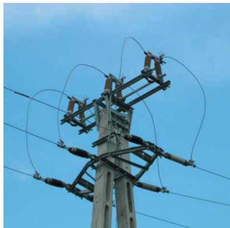
17. fotó: Oszlopkapcsoló: ez az egyik legveszélyesebb szerkezet a madarakra nézve (Fotó: Demeter Iván).
