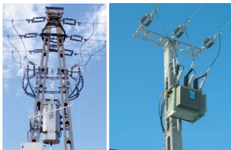
36-37. fotó: Tokozott, oszlopcsücs alatt elhelyezett távvezérelt oszlopkapcsoló és belső biztosítós OTR állomás (Fotó:EDF-DÉMÁSZ).
