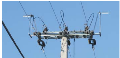
34. fotó: Madarak számára létesített kiülöhely oszlopkapcsolón (Fotó:EDF-DÉMÁSZ).
