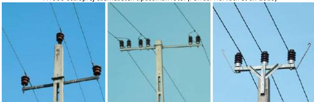
Tartóoszlopok: háromszög vezetőelrendezés (ez a leggyakoribb szerkezet) (1); egysíkú vezetőelrendezés kettős felfüggesztéssel (2); egysíkú szűkített vezetőelrendezés leesésgátlóval (3).
