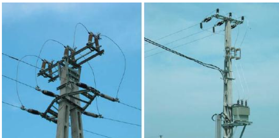
Oszlopkapcsoló: ez az egyik legveszélyesebb szerkezet a madarakra nézve (7); OTR: Oszlop transzformátor állomás (8) (Fotók: Demeter Iván).
